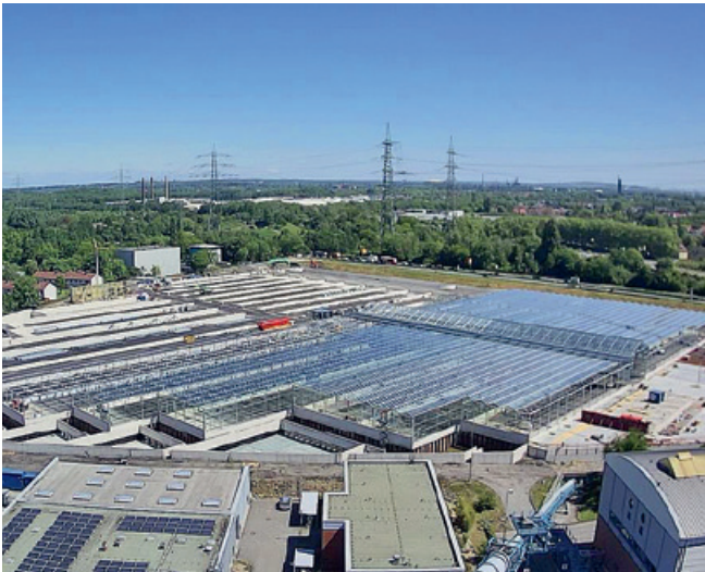
Abb. 8: Solarthermische Trocknung (Stand Mai 2020, Foto: Emschergenossenschaft)
