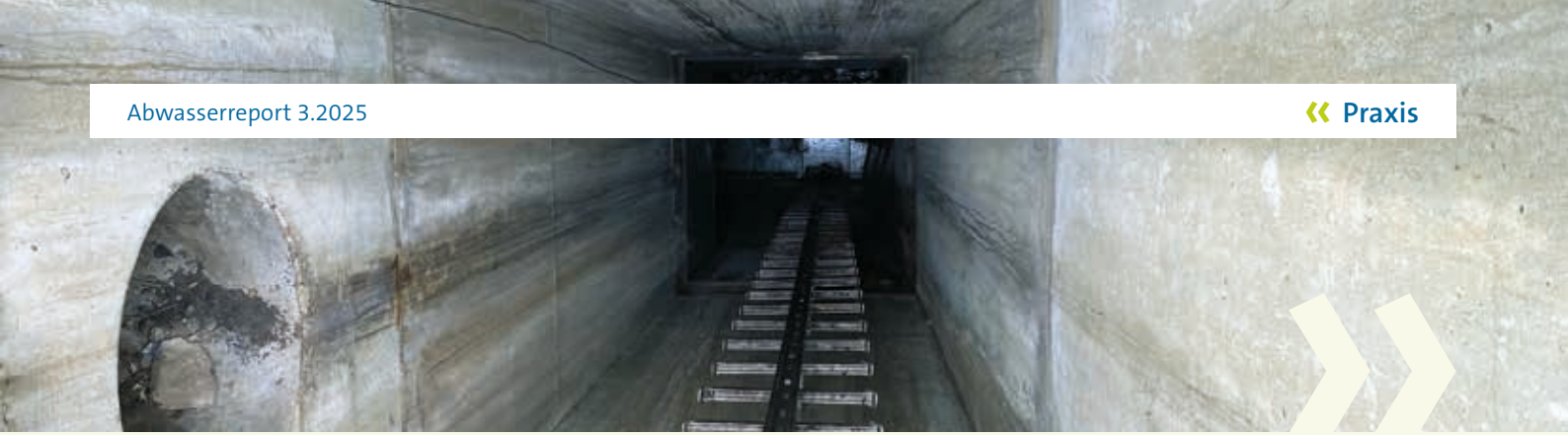
Blick in einen Kanalschacht
